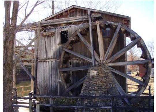
mit Wasserturbinen in Strom verwandelt. Die ersten Wasserräder wurden ca. 200 v. Chr. gebaut. Sie nutzen die ungerichtete Energie des fließenden Wassers. Im einfachsten Fall (Bild links: mittelalterliches Wasserrad) wird das Wasserrad einfach in ein fließendes Gewässer gestellt.
